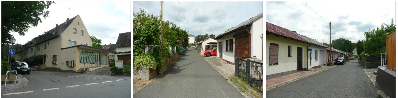
Abb. 29: Leerstehendes Nebengebäude (Laden) am Eichenplatz, umfunktionierte ehem. Werkstätten an der Elias-Placht-Straße, die zu den Wohngebäuden an der Schönbacher Straße gehören
