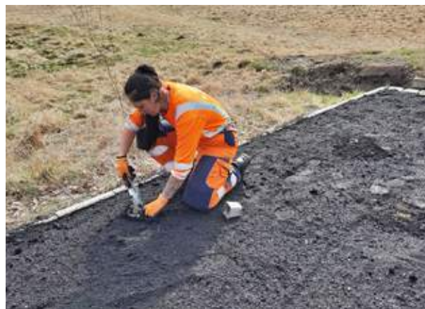
Bauhofmitarbeiterin Jasmin Böhnlein bei der Neuanlage dieser Fläche. Foto: Gemeinde Bubenreuth
