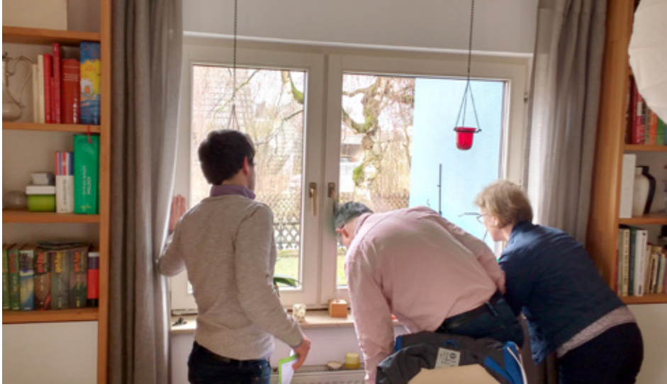
Überprüfung der Fensterverglasung.
