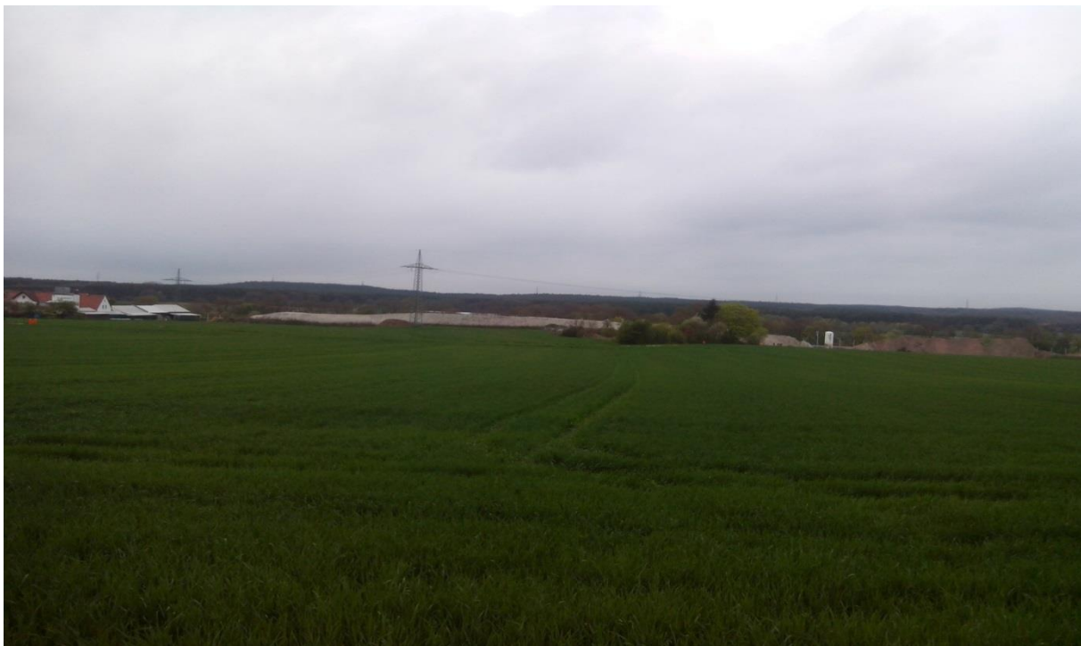
Abbildung 13: Blick von der Birkenallee auf den Lärmschutzwall, Bauabschnitt 1 (Süd), links im Bild
