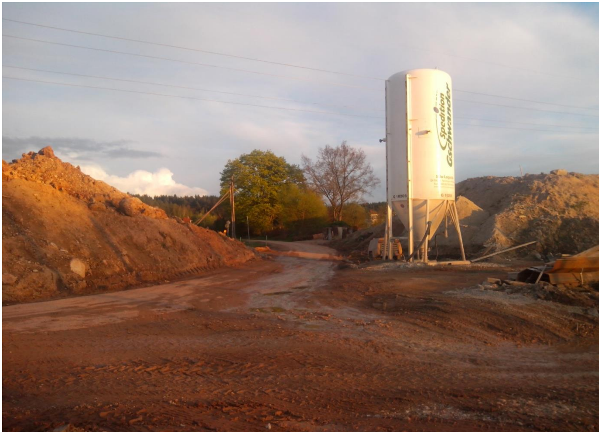
Abbildung 14: Frankenstraße markiert Ende des Bauabschnittes 1 (Süd), rechts im Bild
